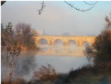
Imagen 59. Puente romano de Mérida
