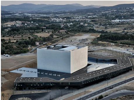
Imagen 1. Centro de datos de PT Telecom en Covilha
