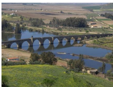
Imagen 56. Puente romano sobre el Río Guadiana. Medellín
