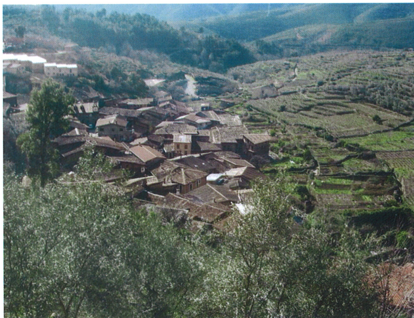
Imagen 30. Detalle de las calles de Robledillo y vista general del casco urbano
